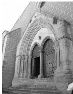
Puerta de los pies del templo (posible obra de acarreo)
