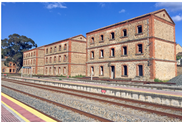
Figura 7. Edificios de viviendas del poblado ferroviario de Monfragüe. Fotografía María Jesús Manzanares.
