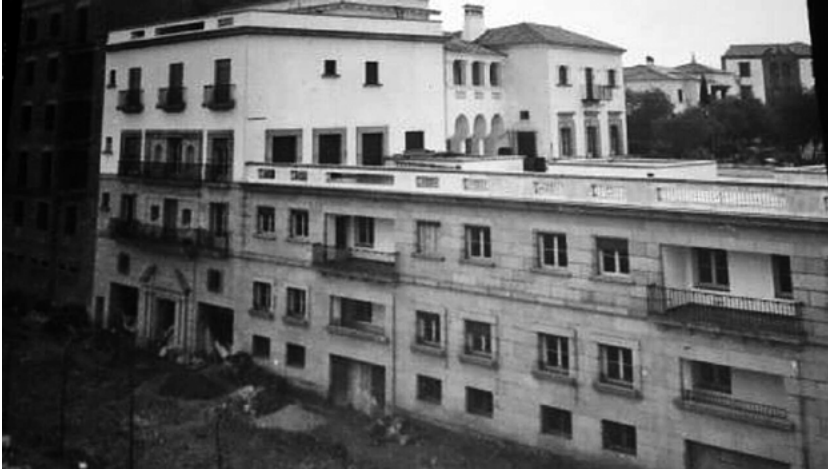
Figura 22. Fachada del hotel Extremadura al terminar la construcción. Arquitecto Luis Morcillo y Villar. Fotografía Archivo Particular.
